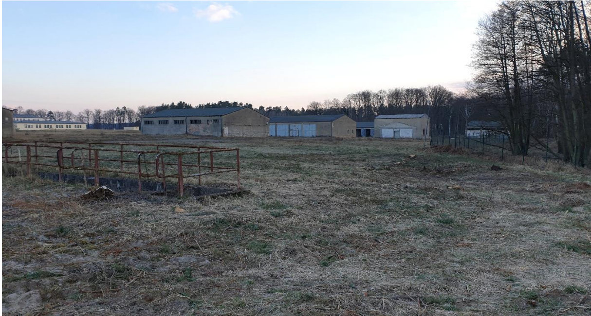
Abbildung 13: Blick auf Gebäudekomplex in nördliche Richtung (Foto Grünspektrum, 20.04.2023)
