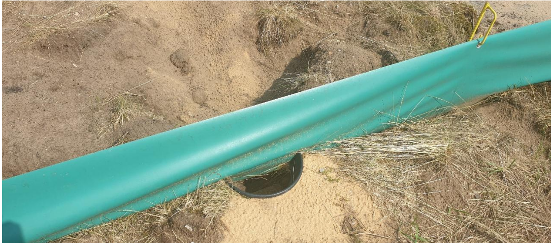
Abbildung 26: Beispiel eines einseitig passierbaren Kleintiertunnels (Foto Grünspektrum)
